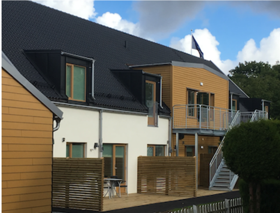
LSS-byggnad i Kattarp, Skåne med sex boendebostäder och ett kontorsrum
