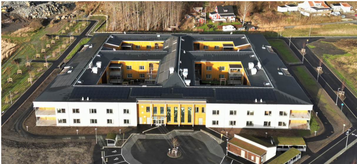
Vård & Omsorgsboende, Björkrisvägen Kungsbacka
