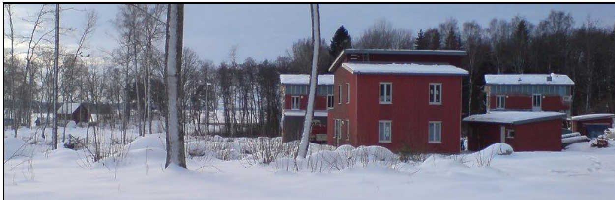
Bild 4.11. Småhus i ett lågenergihusområde, Västerås (beräknad årsenergi 23 - 40 kWh/m 2 , medel 36 kWh/m 2 )
