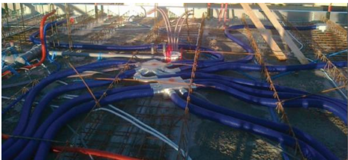
Figur 4. Nya teknik- och systemlösningar kan förväntas sänka kostnaderna när energieffektiva byggnader uppförs. Bilden visar flexibla tilluftskanaler som tar 80 mm i höjd och förenklar dragnings i mellanbjälklag. Ingjutning är dock ingen lämpligt lösning om värme ska bäras med tilluften (luftvärme).
