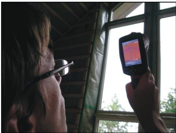
Bild 5: Täthetsmätning sker med Blower Door metoden. Värmekameran visar läckorna som kan rättas till under bygget.
