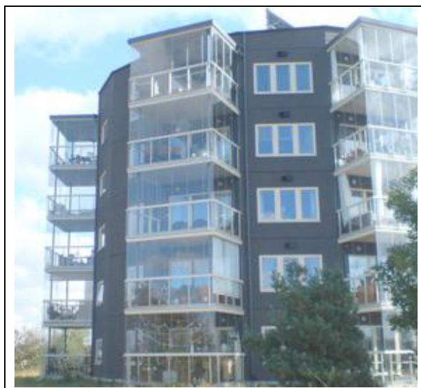
Kv Sjölijan. Tre byggnader med uppmätt 49 kWh/m 2
